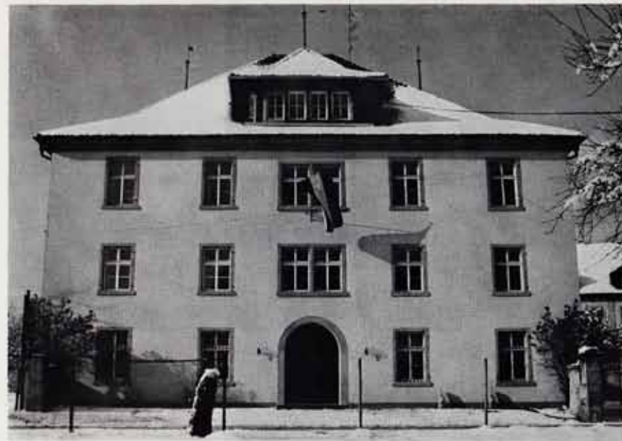
Das Wohnheim mit dem neuen Eingang
